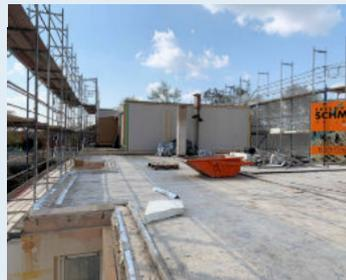
Die Dachgeschosse der Häuser wurden abgetragen und durch ein neues Stockwerk ersetzt. Um das Gewicht der Gebäude zu minimieren und ökologisch zu bauen, wurden die neuen Geschosse komplett in Holzbauweise ausgeführt. Mittels einer neuen, über die Außenwände spannenden Brettstapeldecke, wurden die Wandlasten auf die bestehenden Wände transportiert. Die Lasterhöhung aus der Aufstockung kann der langjährig konsolidierte Baugrund ohne Erüchtigung aufnehmen.
